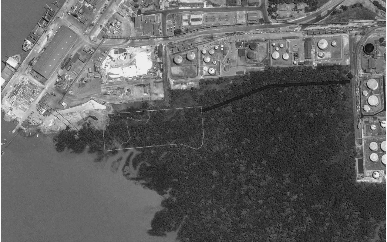
Figura nº 4 - O avanço do aterro progride em 2012...
