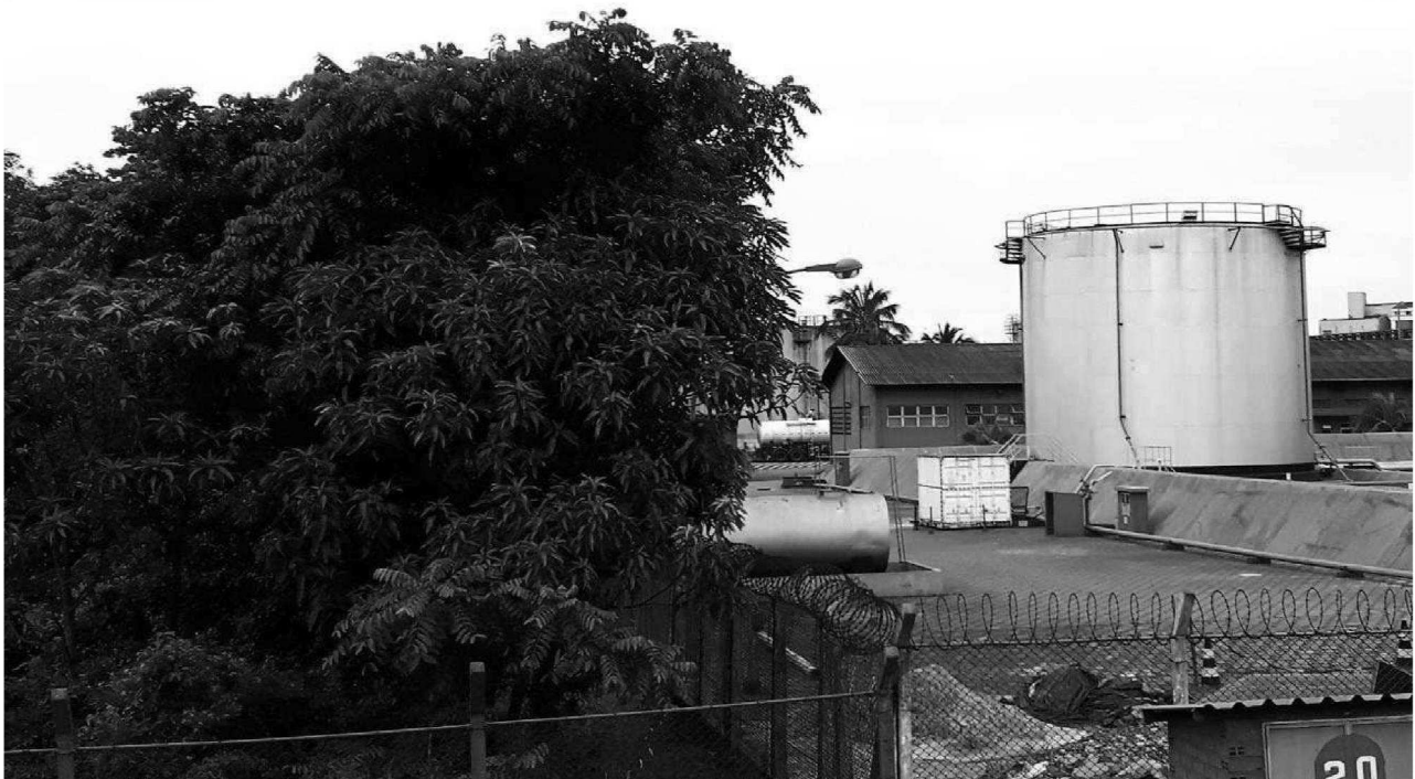
Foto nº 8 - Terreno vizinho ao empreendimento ocupado pelos tanques e instalações da Ipiranga. Destacam-se as árvores exóticas plantadas sobre o manguezal, acompanhando o lado externo do muro.
