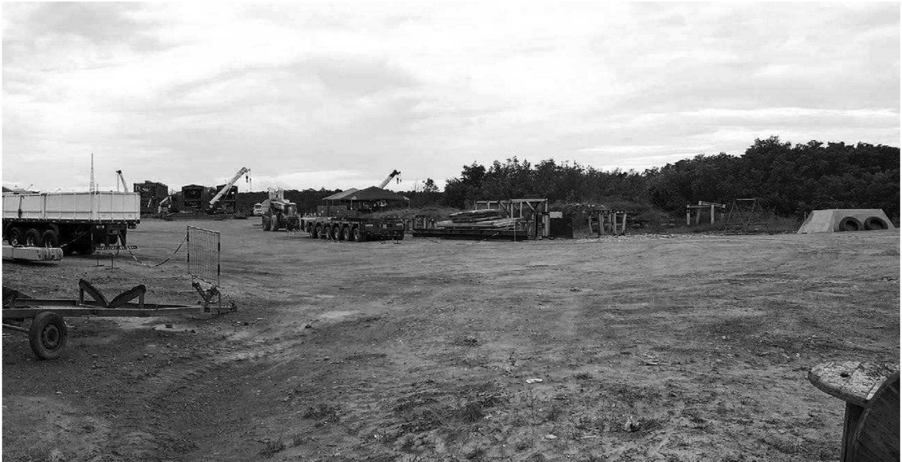
Foto nº 1 - Área a ser ocupada pelo novo armazém vista a partir do portão de entrada de veículos. Atualmente o local é basicamente ocupado como depósito de outros empreendimentos no porto.
